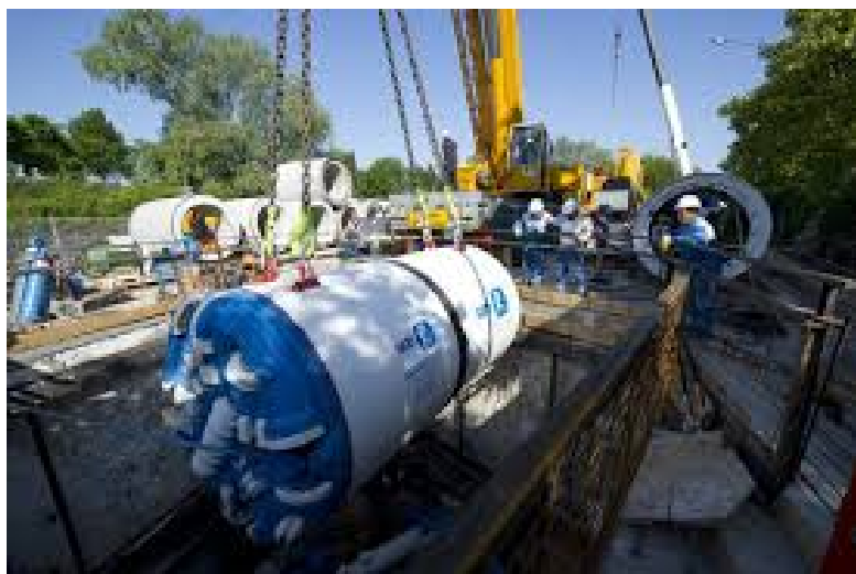
Mise en place Micro tunnelier
