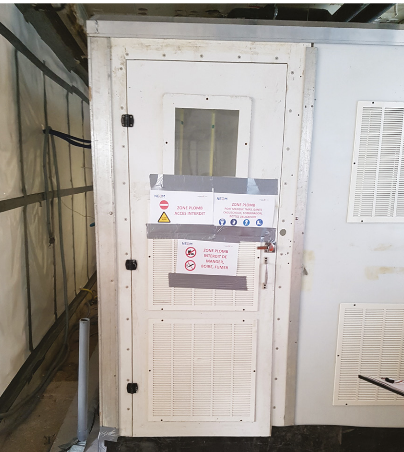
Sas de confinement à trois compartiments sur un chantier de retrait de peinture au plomb.
