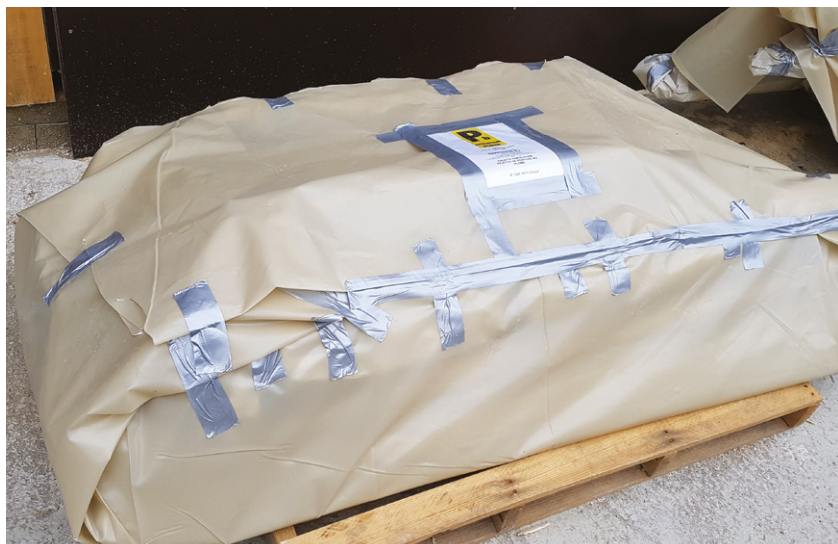
Déchets de matériaux contenant du plomb emballés avant évacuation du chantier.
