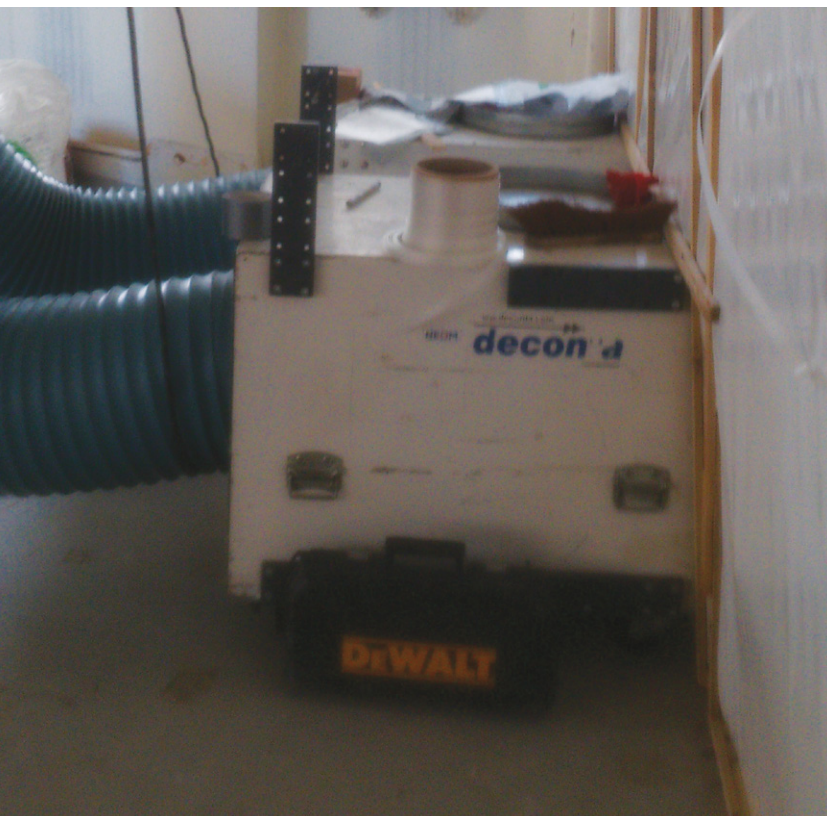
Extracteurs d'air sur une zone confinée d'un chantier d'enlèvement de peinture au plomb.
