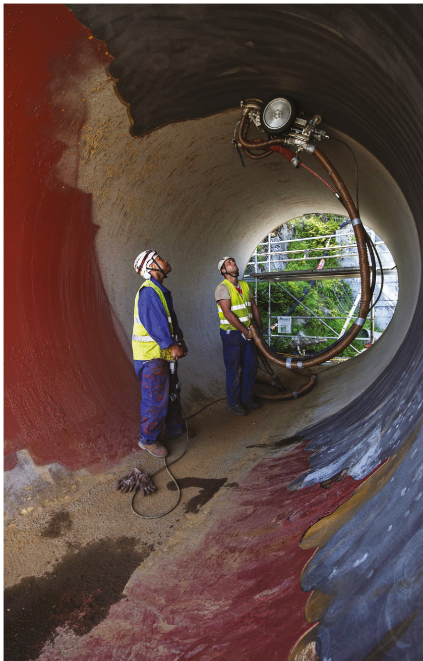
Décapage à ultra haute pression de peinture au plomb avec un robot équipé d'un dispositif de captage à la source.
