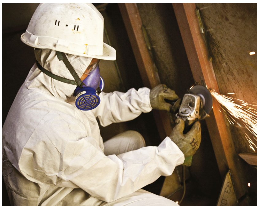
Intervention ponctuelle sur une structure métallique.
