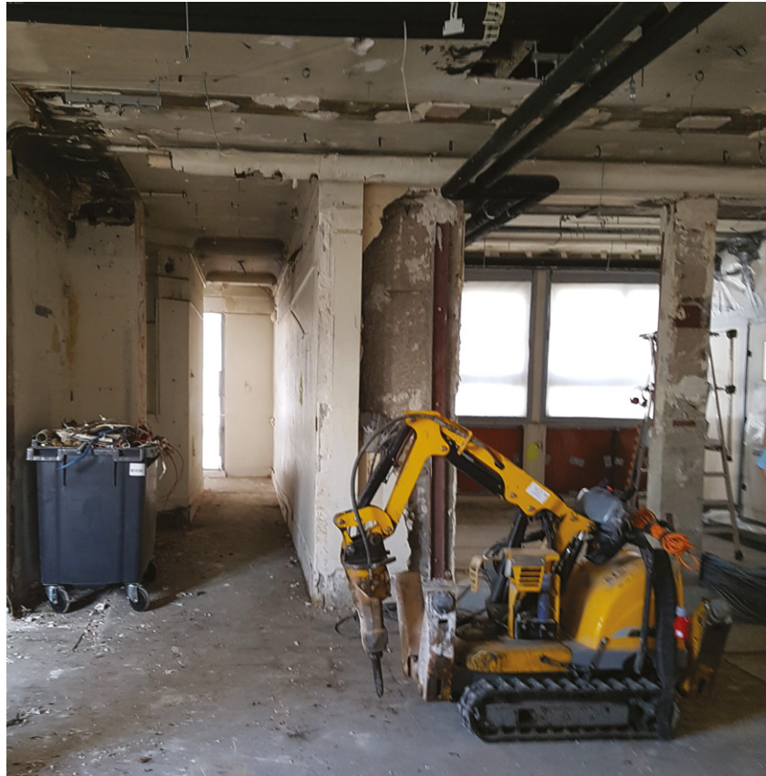
Robot de démolition dans une zone confinée.
