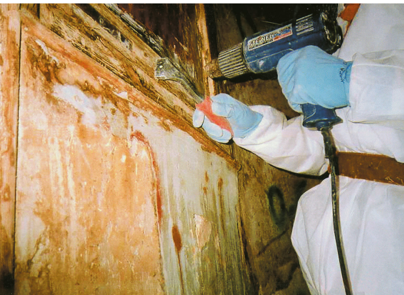
Décapage thermique de peintures sur des boiseries.
