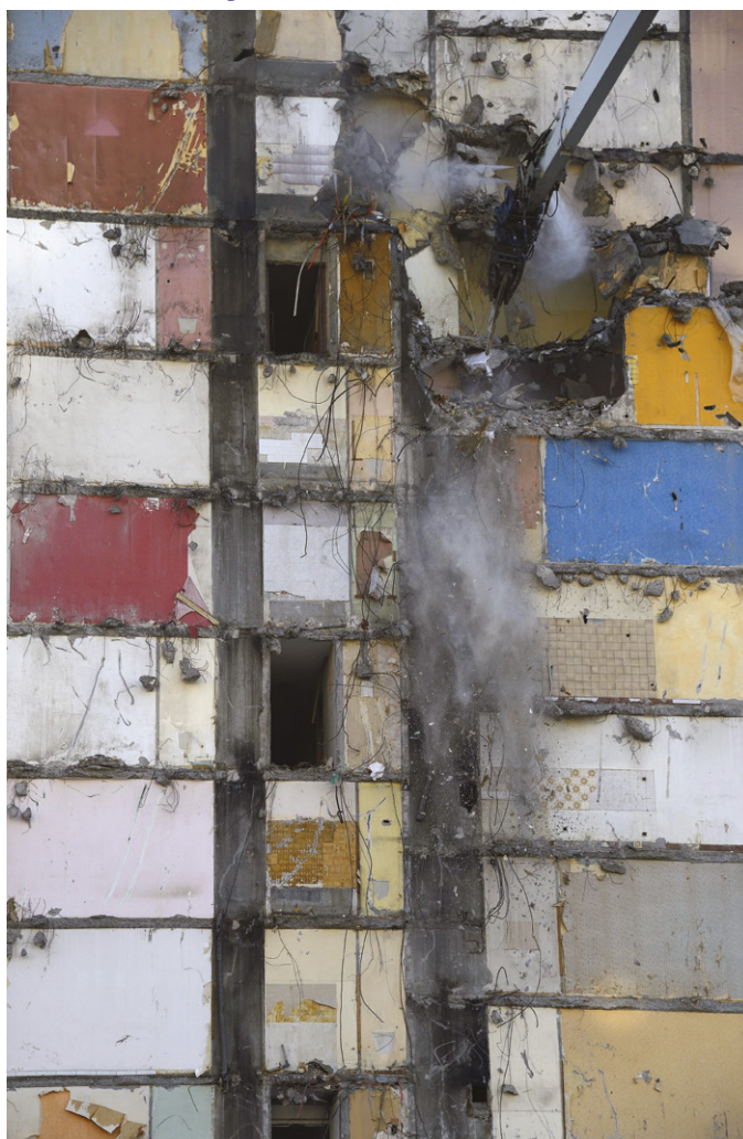
Abattage d'un bâtiment avec brumisation.
