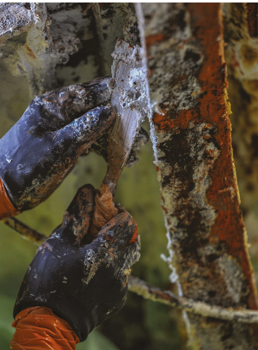
Décapage chimique de peinture au plomb.
